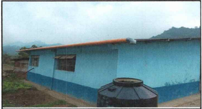
Foto 2: Sustitución de canal pluvial, modulo 1
