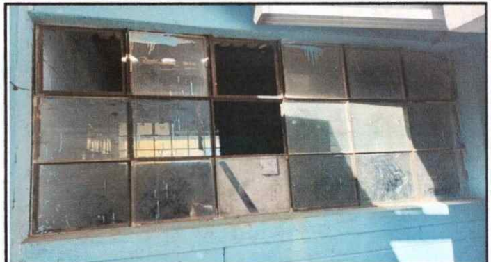
Foto 2: Sustitución de estructuras; ventanas y vidrios, modulo 1 y 2
