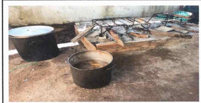
Foto 5: Se requiere sustitucion de estufa rural, modulo cocina.
