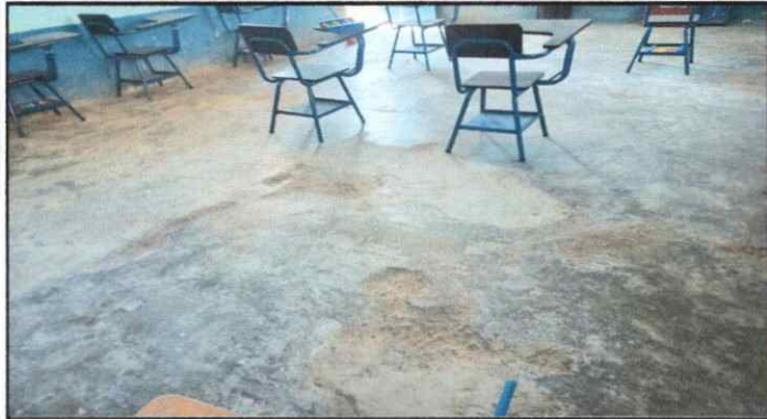
Foto1: Sustitución a piso de granito, modulo 2.
