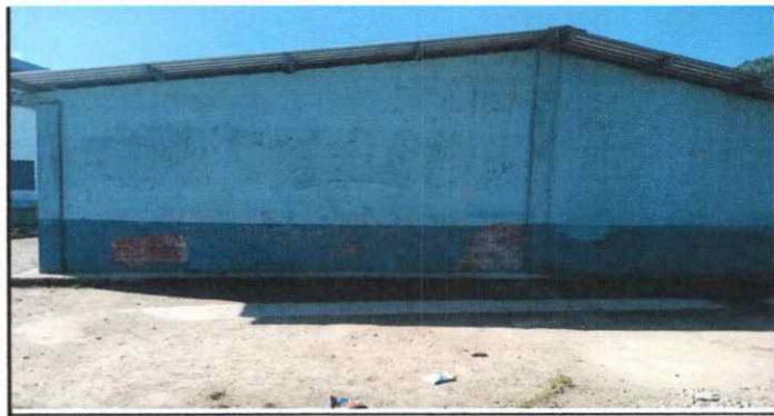
Foto 5: Reparación de muros o paredes, modulo 1 y 2
