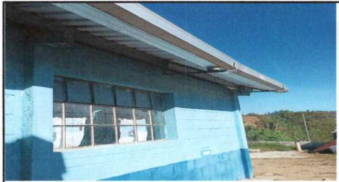
Foto 3: Sustitución de canal pluvial, modulo 1
